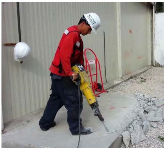
*Imagen B.9- Rotura de vereda de hormigón con rotopercutor*
