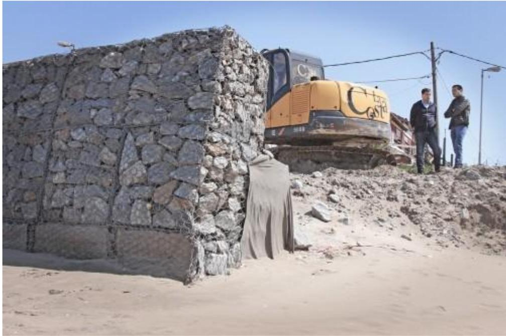
Imagen B.6 Geotextil entre contacto suelo- gavión
