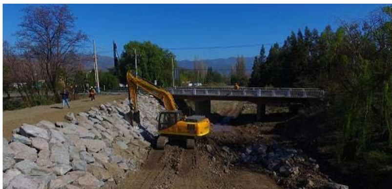
*Imagen B.10- Retroexcavadora colocando el enrocado en el talud.*
