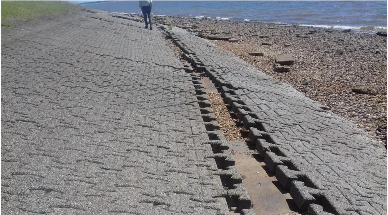
Imagen B.2- Desplazamiento de la pollera de protección por rotura y desintegración del hormigón de vinculación entre partes. Socavación del pie por oleaje (Lado Norte).
