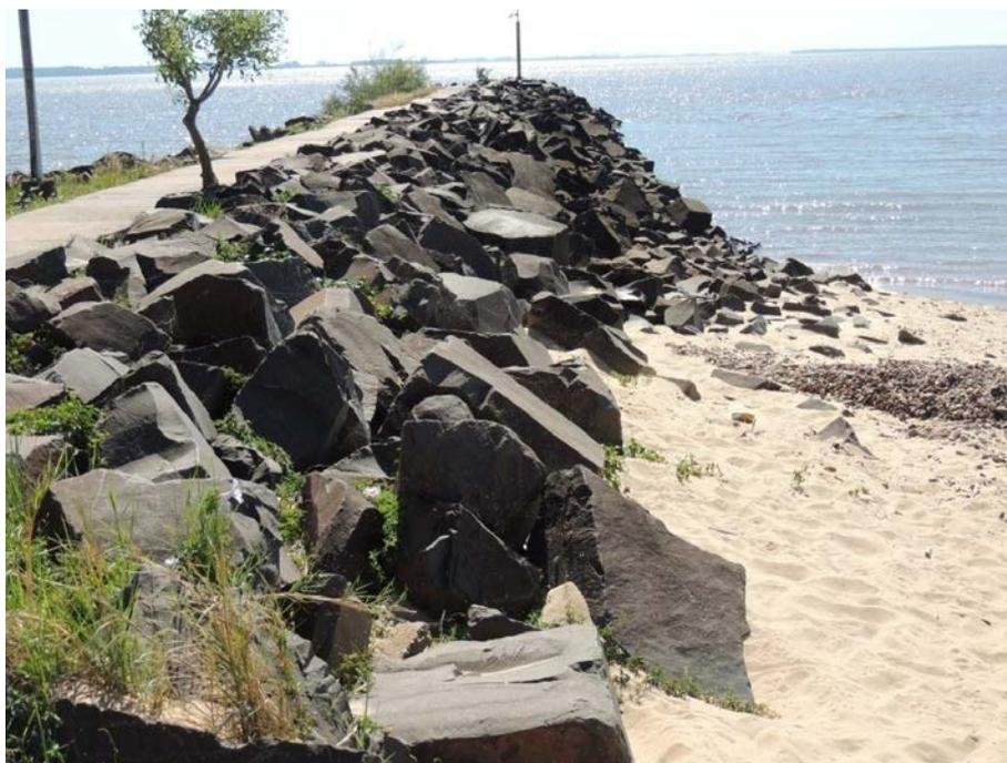
*Imagen B.3- Estado actual de la coraza de protección del talud lado Sur.*
