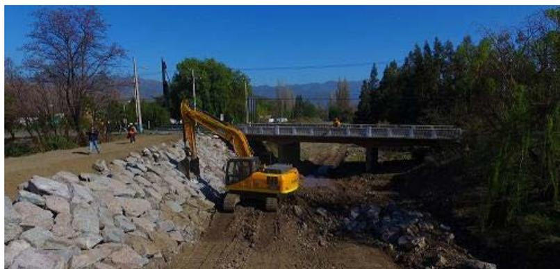
*Imagen B.5- Retroexcavadora colocando el enrocado en el talud.*
