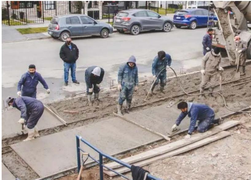
*Imagen B.11- Ejecución de vereda utilizando vibrador de inmersión.*
