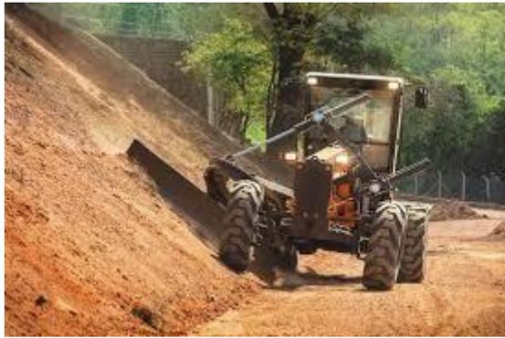
*Imagen B.3- Perfilado de taludes.*
