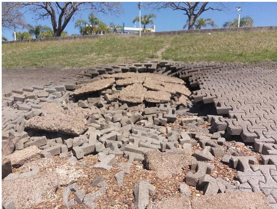
Imagen B.1- Afectación localizada de la protección. Vista desde el pie del talud.
