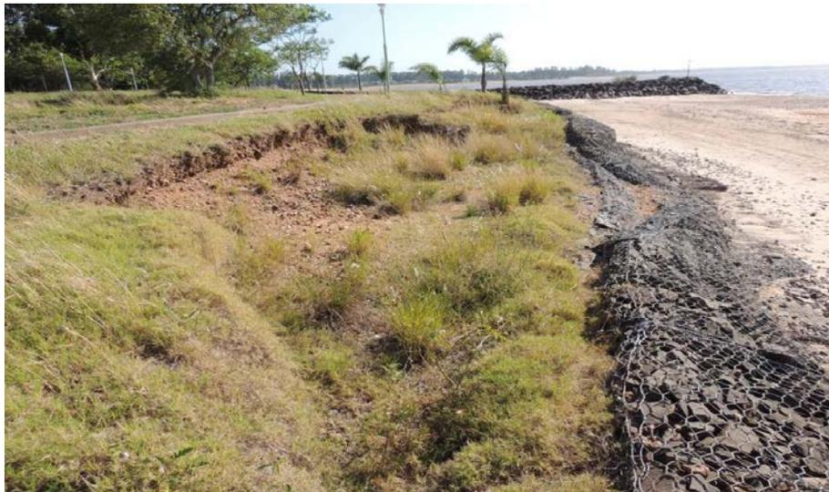
*Imagen B.7- Erosión con desplazamiento del suelo superior, incrementando el empuje sobre el muro de gaviones.*
