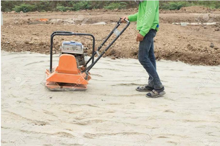
Imagen B.7- Compactación manual con placa vibratoria.
