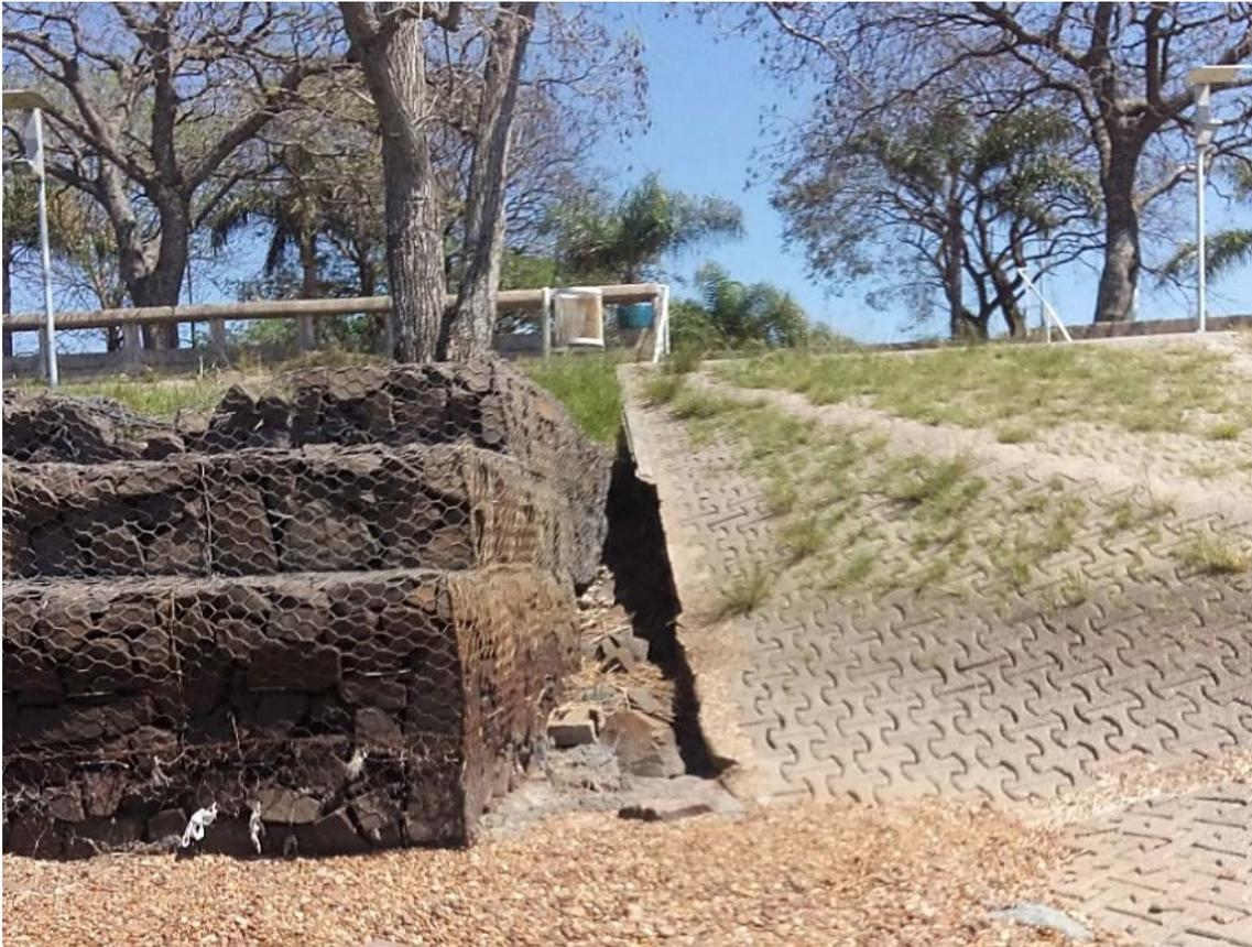
Imagen B.3- Erosión en extremo Sur de la protección con CODE.
