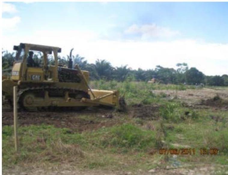
*Imagen B.2- Topadora realizando tareas de desmalezamiento.*
