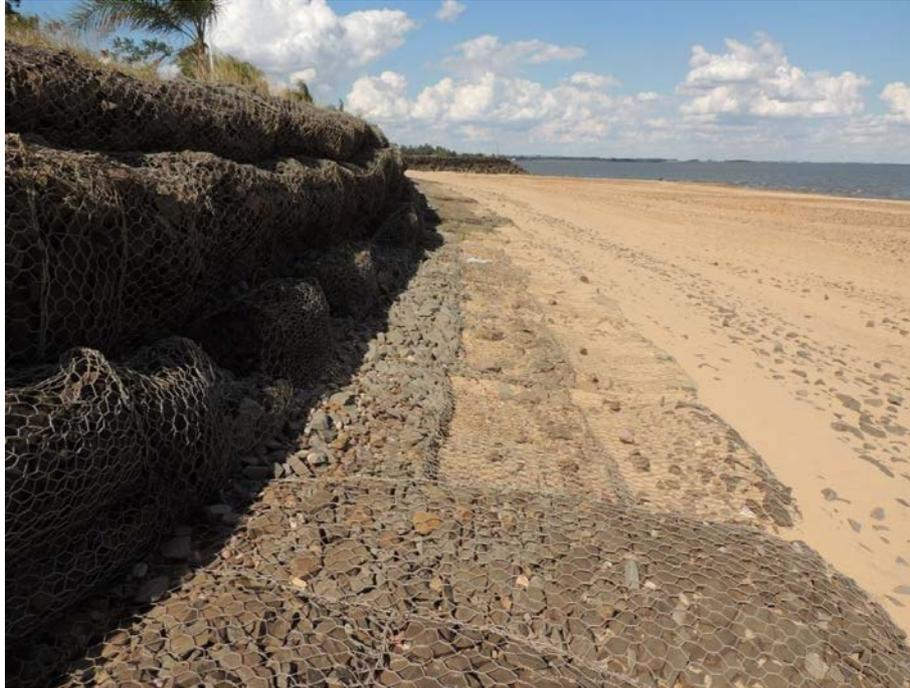
*Imagen B.6- Vista del muro de gaviones y colchonetas, en un sector deteriorado.*
